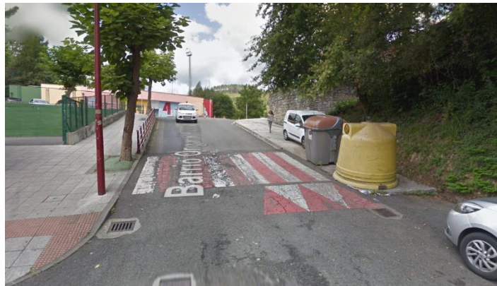
Figura 37. Pasos para los peatones elevado y con pintura roja delante de Ongarai Eskola. Fuente: elaboración propia.
